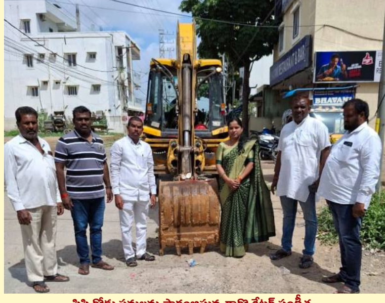
సిసి రోడ్డు పనులను ప్రారంభిస్తున్న కార్పొరేటర్ సంగీత
